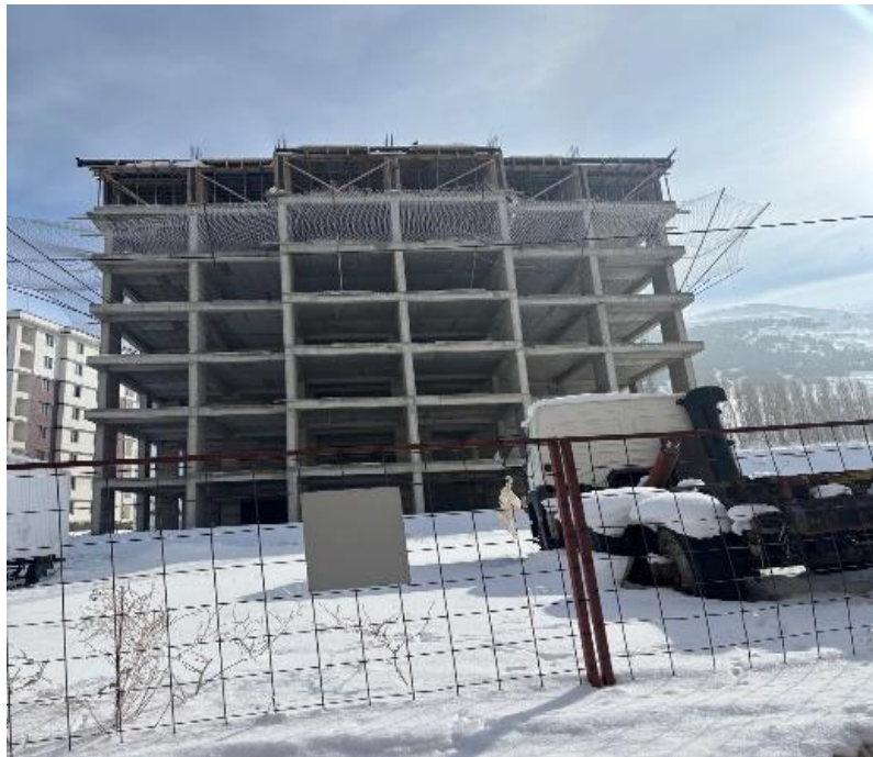
Resim 2. Kalıp Aşamasında Şantiye Görüntüsü
