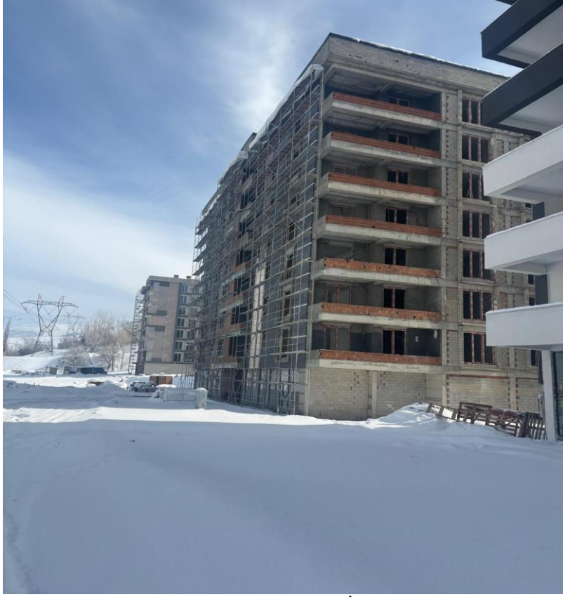
Resim 4. Tek Taraflı Kurulmuş İskele Görüntüsü
